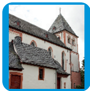
Sankt Petrus, Lüftelberg Petrusstraße
