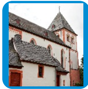
Sankt Petrus, Lüftelberg Petrusstraße
