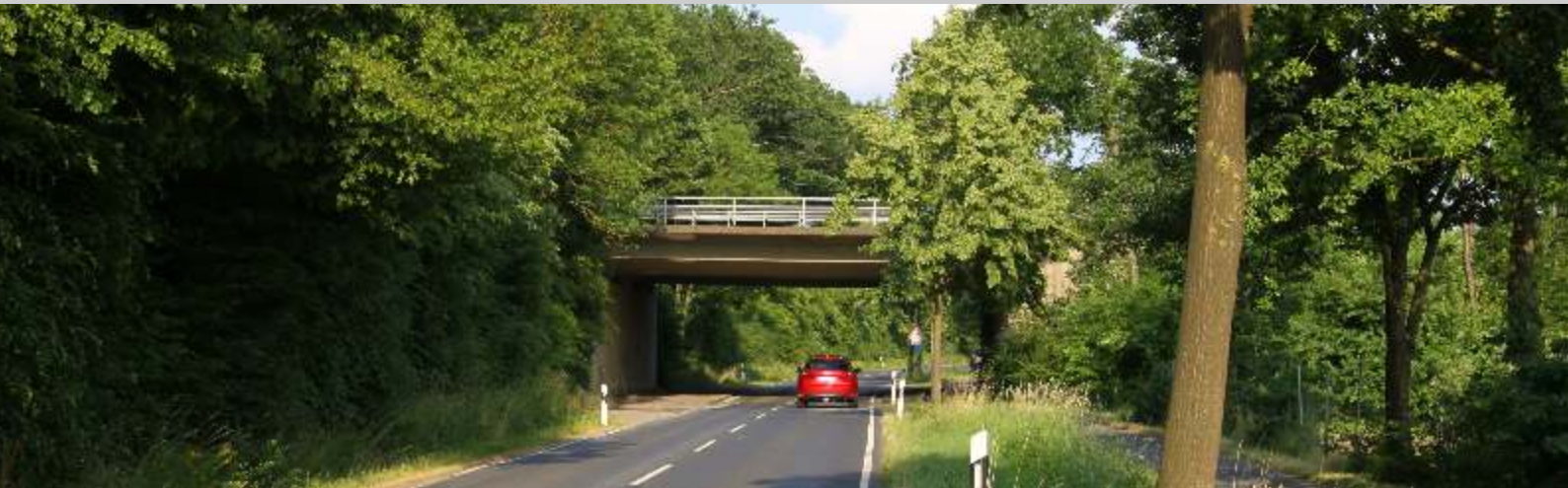
Brücke der A 565 über die Landstraße zwischen Adendorf und Meckenheim
