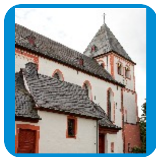
Sankt Petrus, Lüftelberg Petrusstraße
